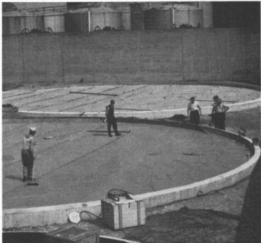
Abdichtung von Stehtankfundamenten mit ölbeständiger, in- und ausländisch geprüfter IRONFLEX-Folie.
