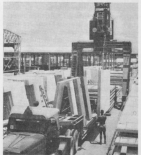
Bild 2. Lagerung und Abtransport der Fertigbauteile
