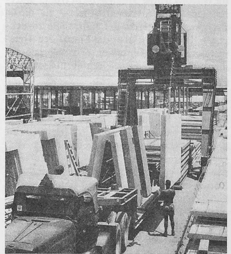
Bild 2. Lagerung und Abtransport der Fertigbauteile
