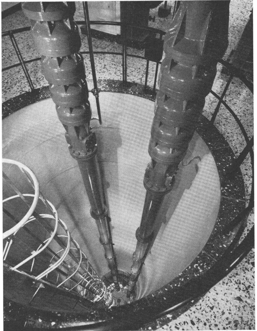
Sulzer-Bohrlochpumpen im Grundwasserpumpwerk Hard II der Wasserversorgung Lenzburg. Jede Einheit fördert 150 l/s auf 132 m.
