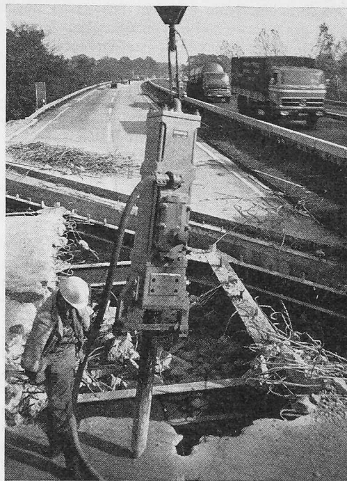
Bild 1. Felsbrecher VR 15 A beim Abbruch der alten Fahrbahndecke, während auf der Gegenfahrbahn der Verkehr unbehindert weiterrollt
