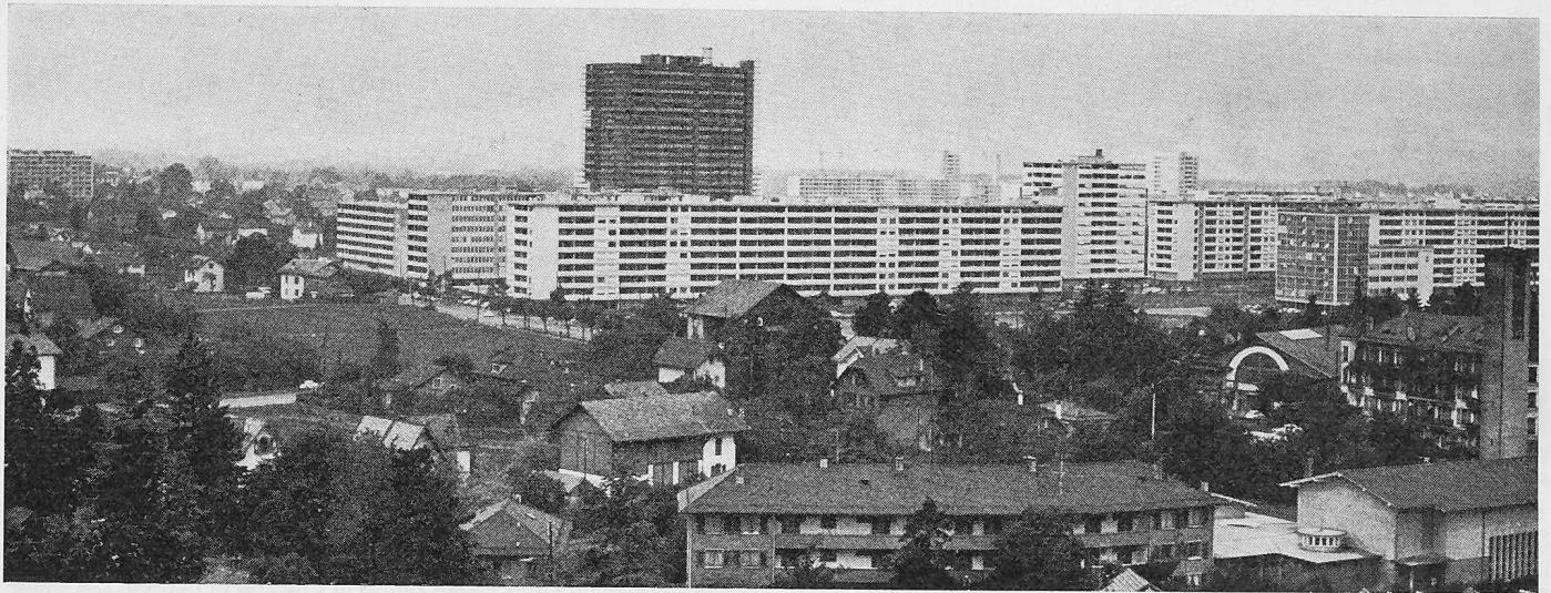
Bild 1. Die Grossiedlung «Cité Nouvelle» in Onex bei Genf
