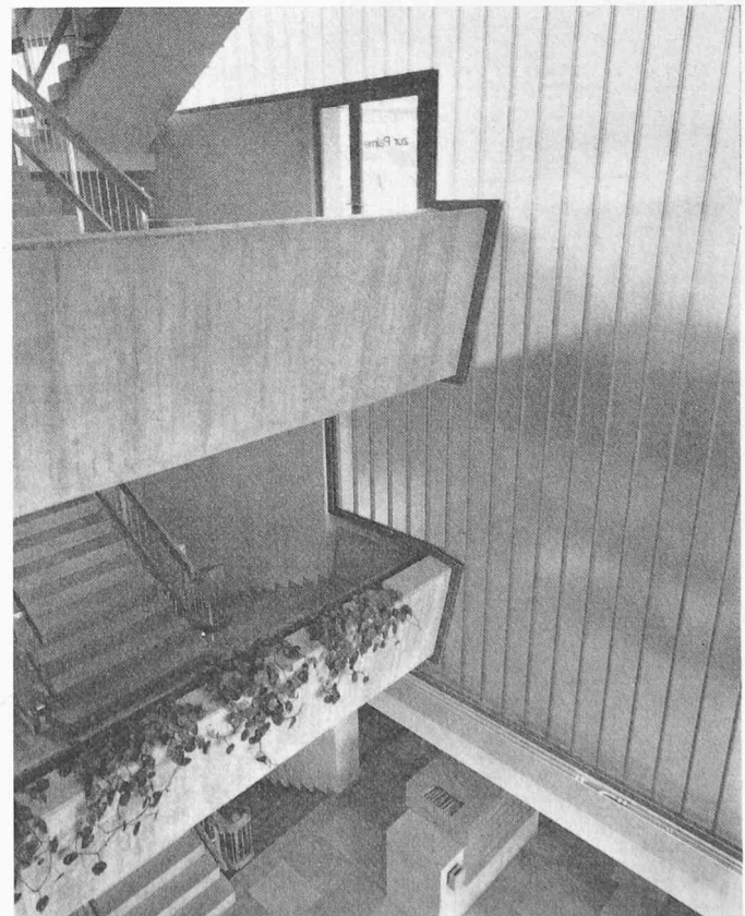
Bild 5. Treppenhalle mit Beton-Podestbrüstungen und Glaswand
