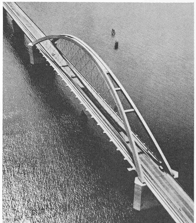
Bild 43. Fehmarnsundbrücke mit bogenüberspannten Balken in der Hauptöffnung
