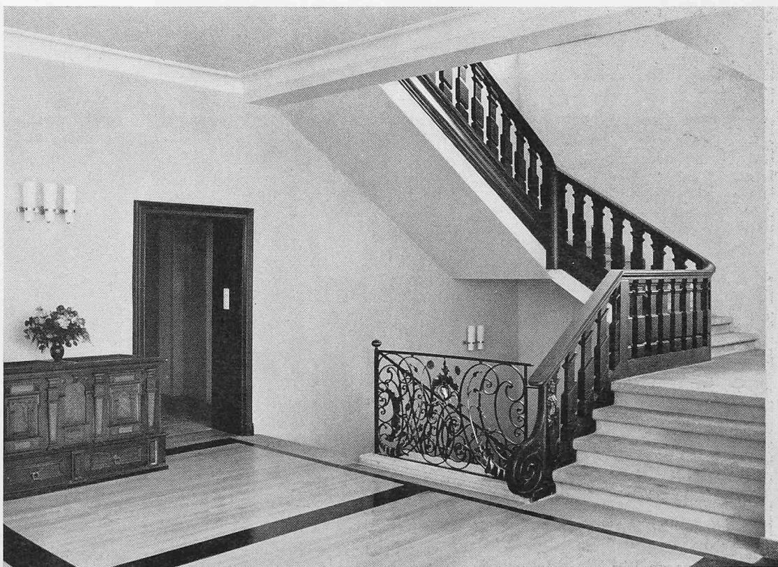
Treppe 1. Stock 1964. Neue Kalksteinstufen, Holzgeländer Eiche von 1685. Geschmiedetes Rokokogeländer von 1762 (ergänzt)
