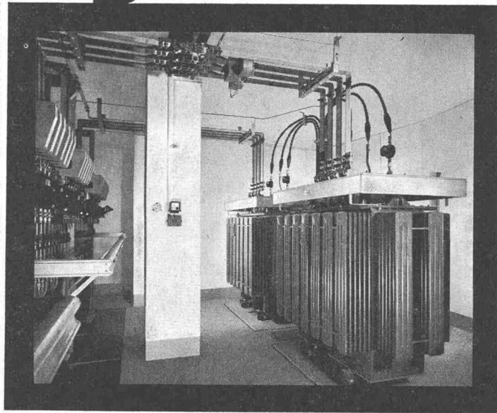
Diese zwei Netztransformatoren aus der normalisierten Reihe der SA des Ateliers de Sécheron, Genf, für je 1000 kVA,  $17500 \pm 3\%/394-228$  V sind mit der unbrennbaren Isolierflüssigkeit Pyralen gefüllt.
