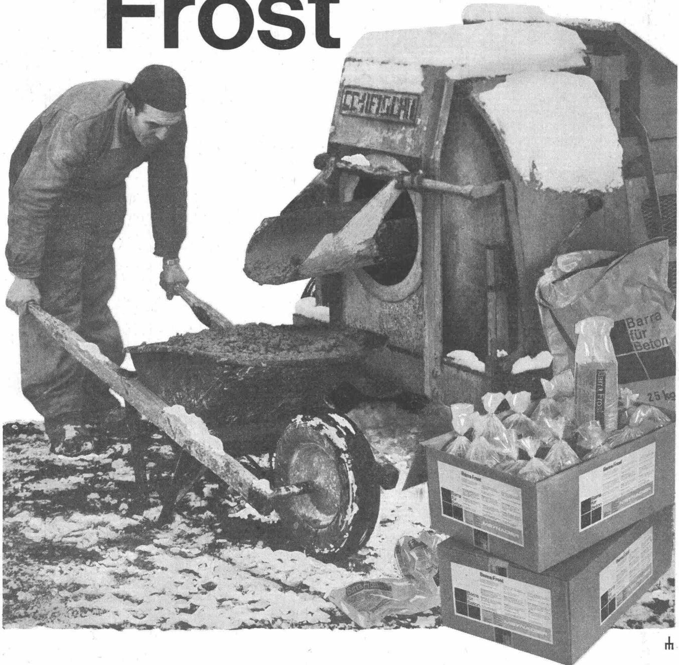
Barra Frost, das sicher wirkende Frostschutzmittel von Meynadier ermöglicht das Betonieren bei Temperaturen bis zu  $-7^{\circ}\text{C}$ . Barra Frost plastifiziert, erniedrigt den Ge-
