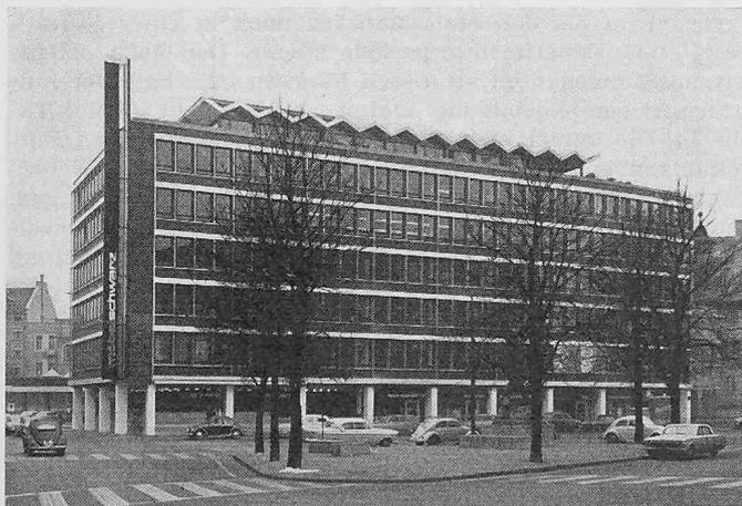
metallrastrer 15 cm vor die Fassaden gehängt wurden. Diese Konstruktion bietet den besonderen Vorteil, dass die Sonnenstrahlen vor dem Auftreffen auf die Fassade abgehalten werden und zudem eine Luftzirkulation zwischen Storen und Fassaden möglich ist.
