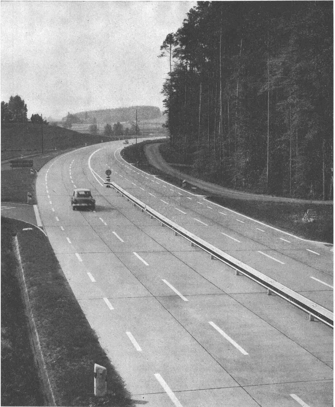
Nationalstrasse 3, Klasse N 4, Winterthur-Schaffhausen, Abzweigung Henggart ZH, Gesamtbreite 15 m, mit Trennschranke, Radstreifen 2×1 m (künftiger Endausbau)
