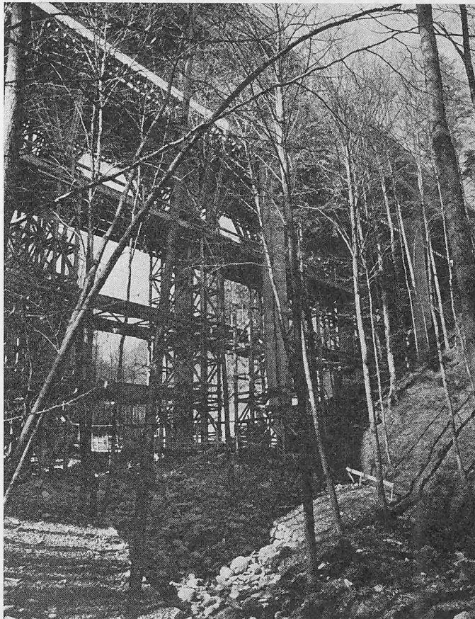
Bild 1 (rechts). Ansicht der Brücke vom Wanderweg aus durch das Mühletobel. Grosse Spannweiten wären hier zu aufwendig
