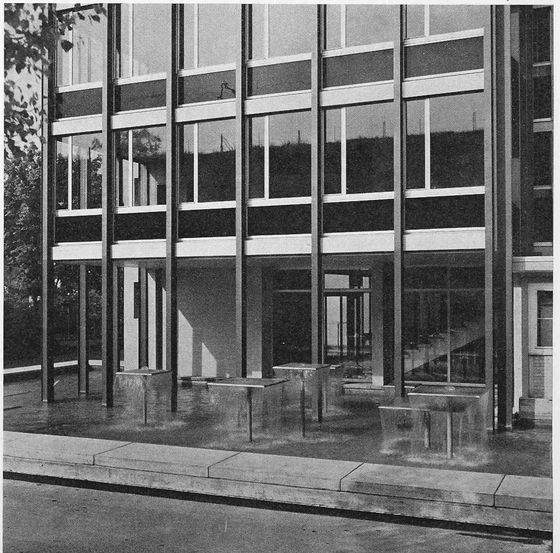
Wasserspiele beim Hauptein- gang des Büro-Hochhauses
