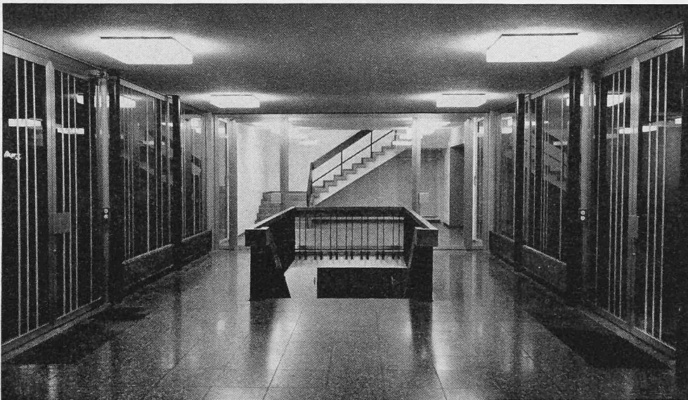
Werkeingang für die Arbeiter und Abgang zu den Waschräumen
