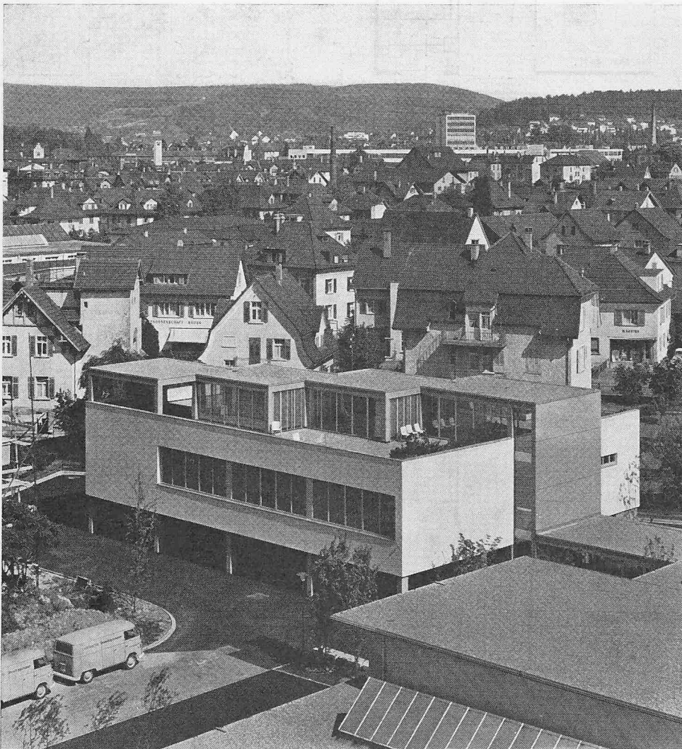
Blick vom Büro-Hochhaus auf das Wohlfahrtshaus
