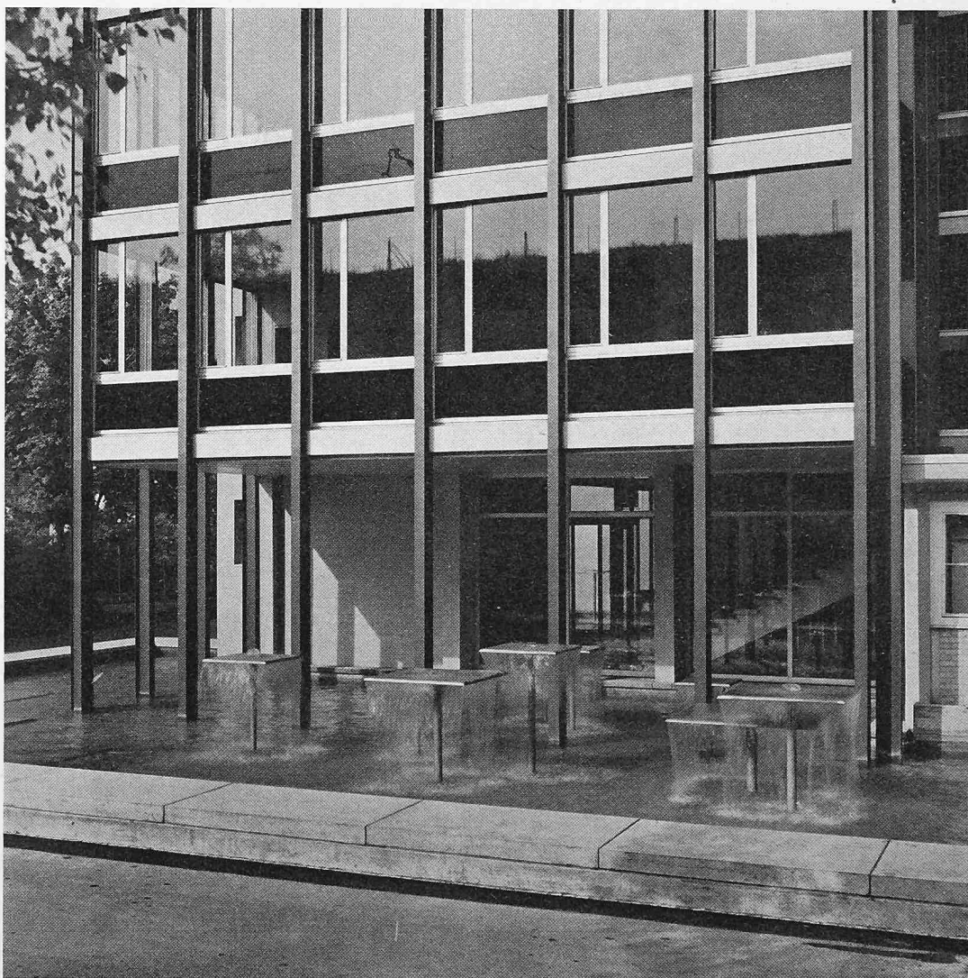
Wasserspiele beim Hauptein- gang des Büro-Hochhauses
