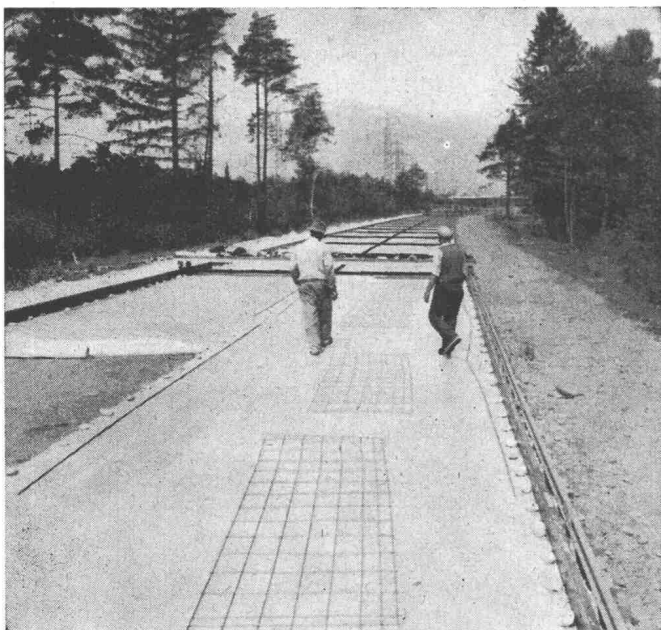
Polyäthylen «Howagaine» im Strassenbau
