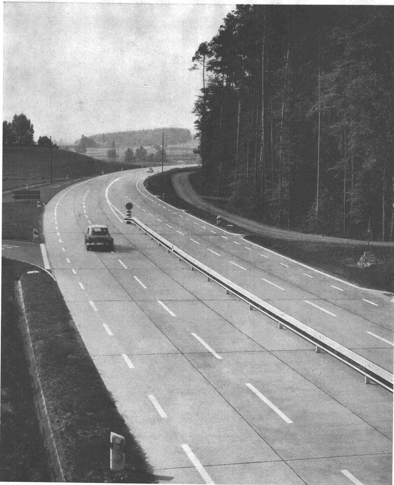
Nationalstrasse 3, Klasse N 4, Winterthur-Schaffhausen, Abzweigung Henggart ZH, Gesamtbreite 15 m, mit Trennschranke, Radstreifen 2x1 m (künftiger Endausbau)
