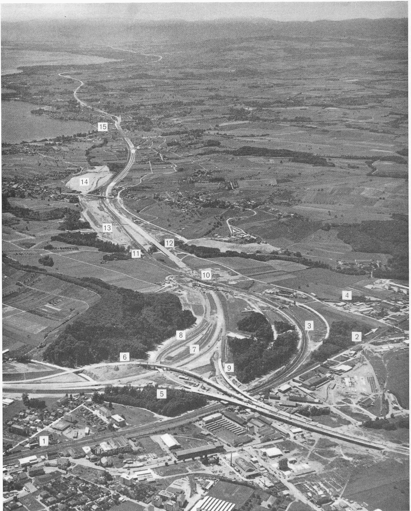
Blick aus Nordosten auf das Autobahndreieck bei Ecublens (vgl. SZB 1963, H. 15, S. 231). Photo Yves Debraine, Le Mont sur Lausanne
