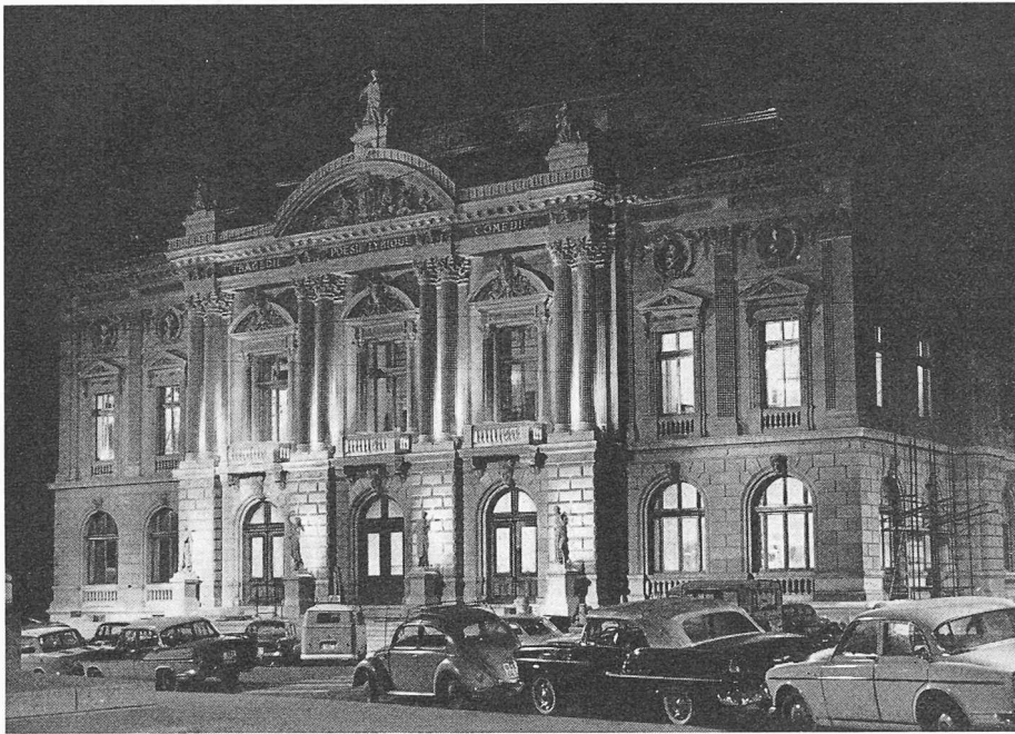
Renovierte Hauptfassade (Eingangsseite gegen Place Neuve)
