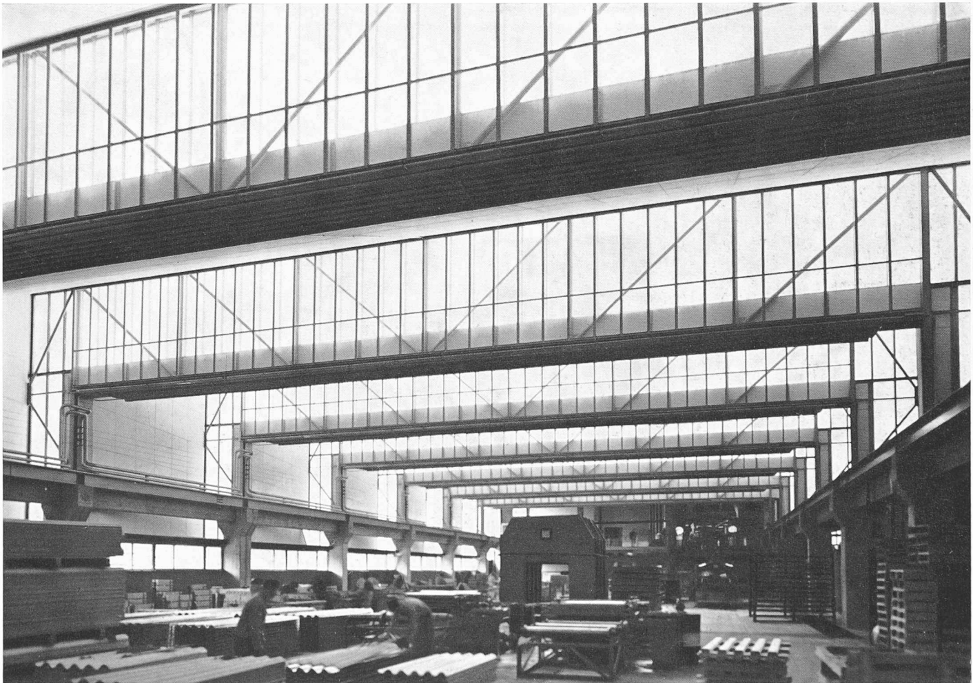
Fabrikhalle, links Westseite, unten Innenansicht
