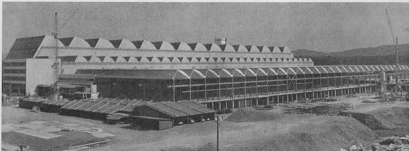
Bild 1. Shedhalle im Birrfeld (Brown, Boveri) mit vorfabrizierten Elementen von 9 x 18 m
