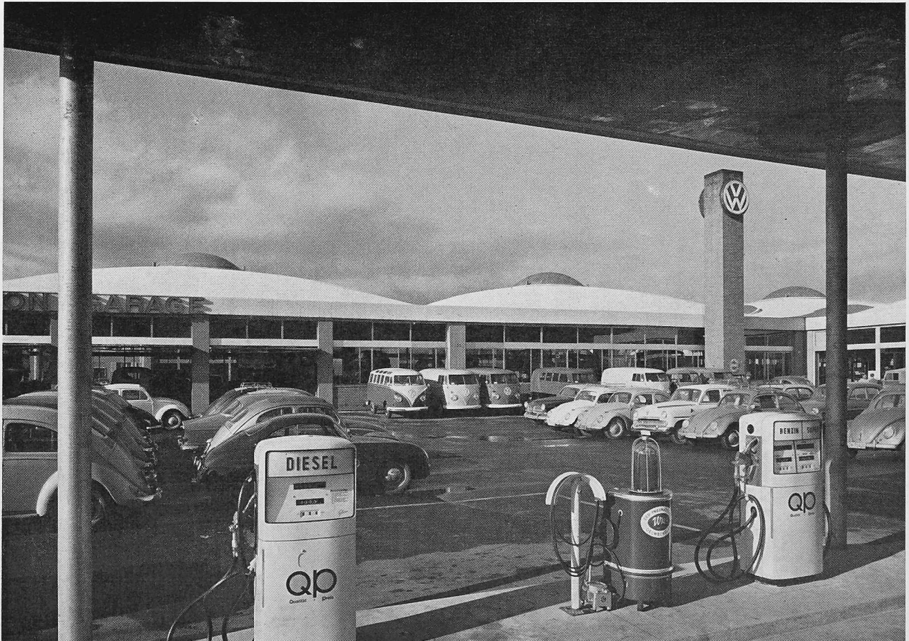
Ansicht von der Tankstelle gegen den Werkstatt-Trakt
