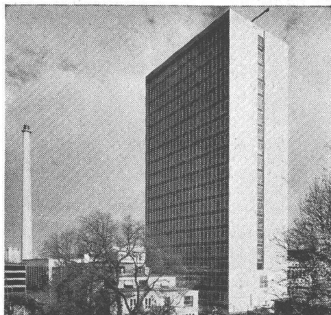
Im Hochbau für hohe Festigkeiten
