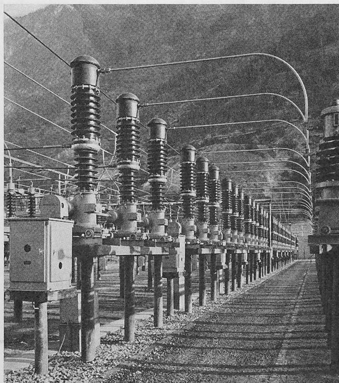
Fig. 49. Station de couplage Creux de Chippis. Disjoncteurs 65 kV
