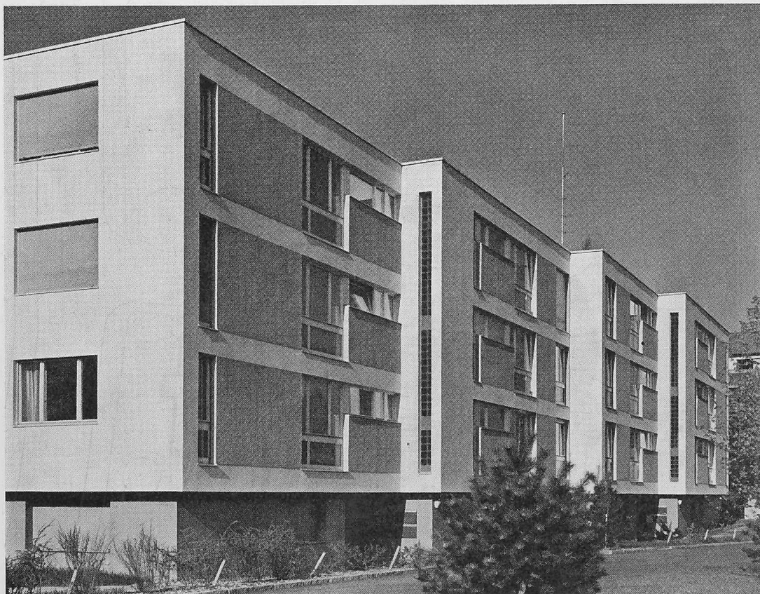
Rückfront des gestaffelten Gebäudes aus Nordosten
