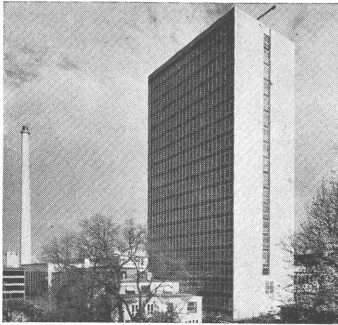
Im Hochbau für hohe Festigkeiten
