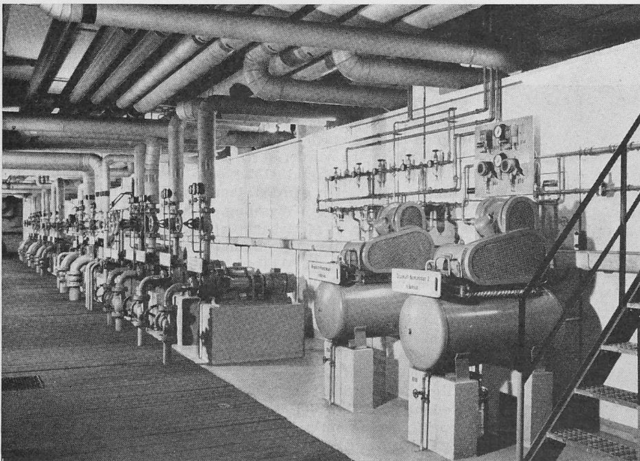
Bild 5. Umwälzpumpen und Druckluftkompressoren in der Wärmezentrale
