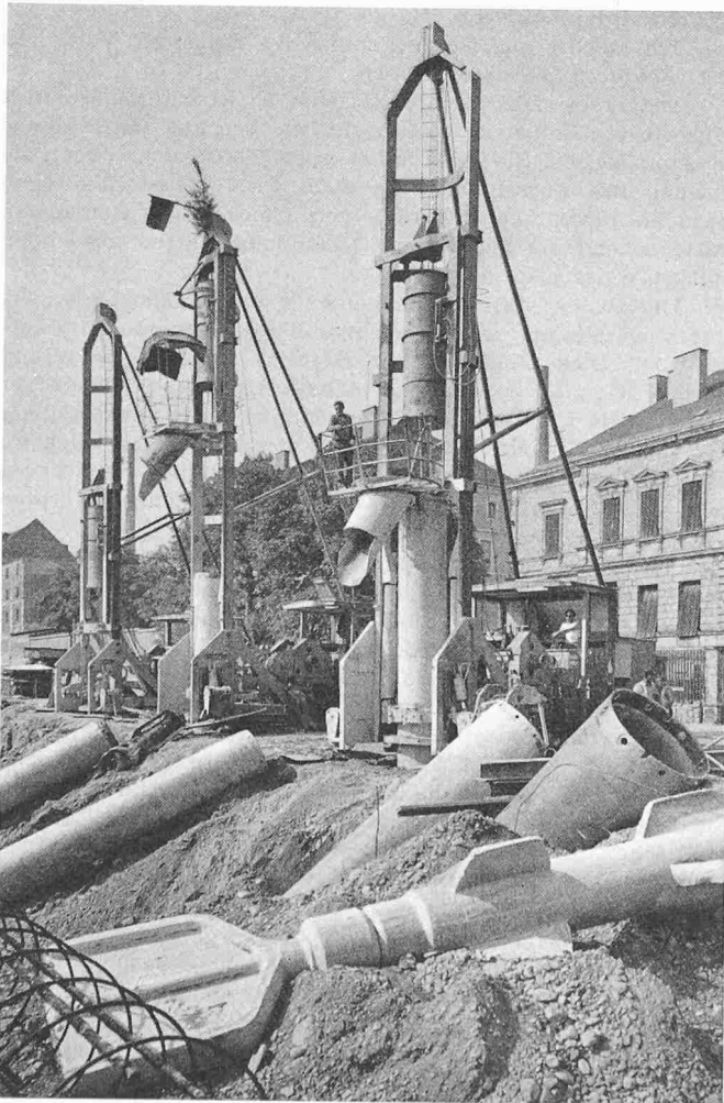
Bild 1. Benoto-Bohrpfahlmaschine EDF 55
