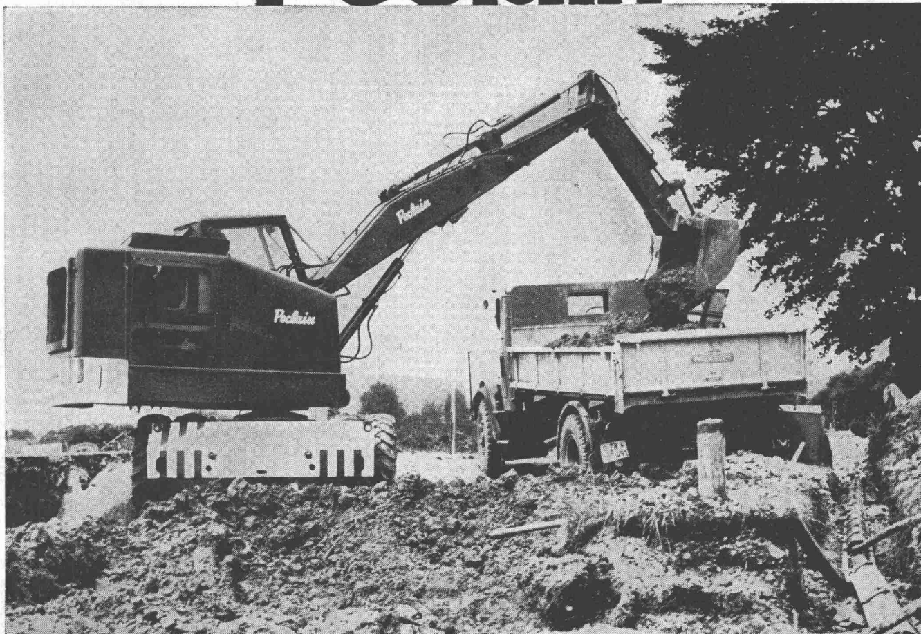
Unser Bild: Verladearbeiten im Strassenkoffer
