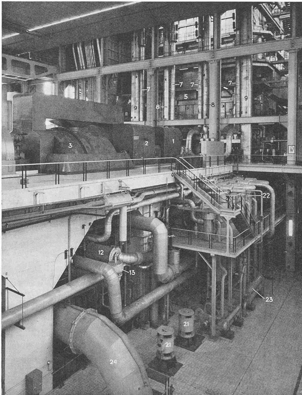
Bild 24. Die Turbogruppe mit Kessel (hinten) und Niederdruck-Vorwärmer (unten). Man beachte die kurzen Verbindungsleitungen zwischen Kessel und Hochdruck-turbine
