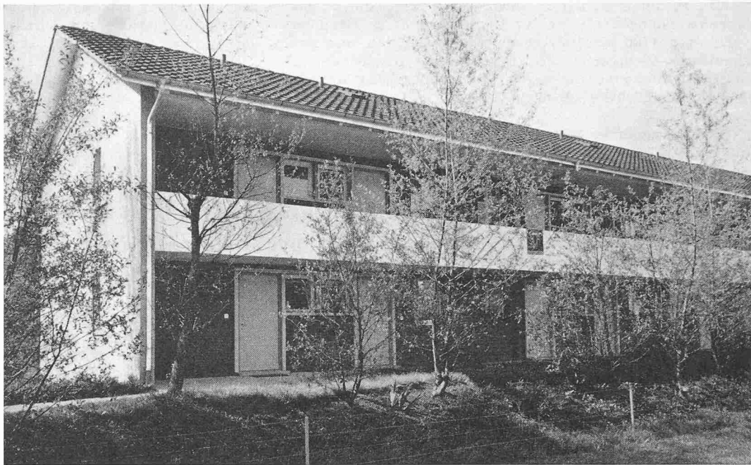
Bild 40. Alterswohnungen an der Endlikerstrasse. Südtrakt der Ueberbauung mit der nördlichen Eingangsseite zu den Wohnungen (im Obergeschoss über den Laubengang). Architekt R. Favero, Winterthur
