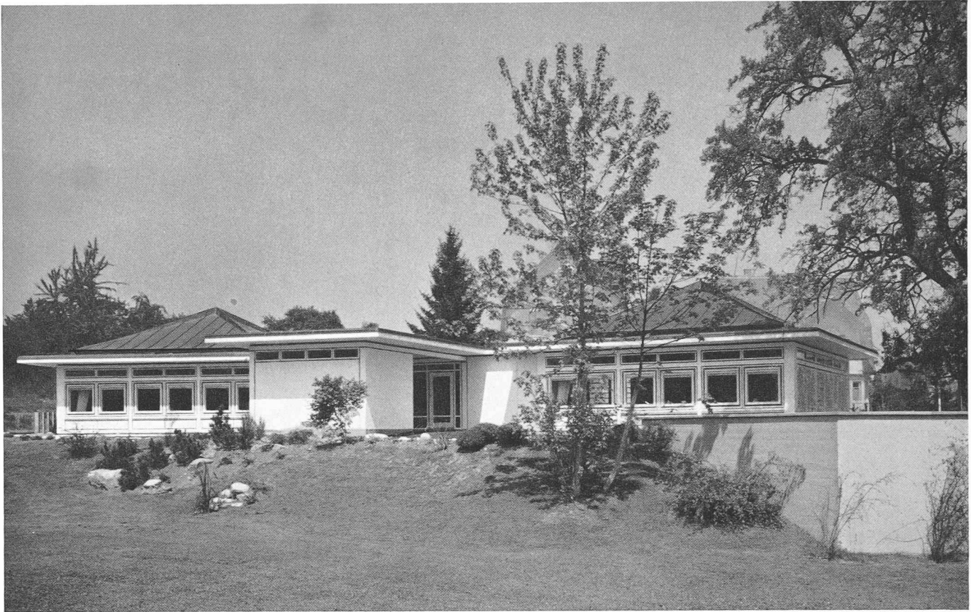
Ansicht aus Südosten
