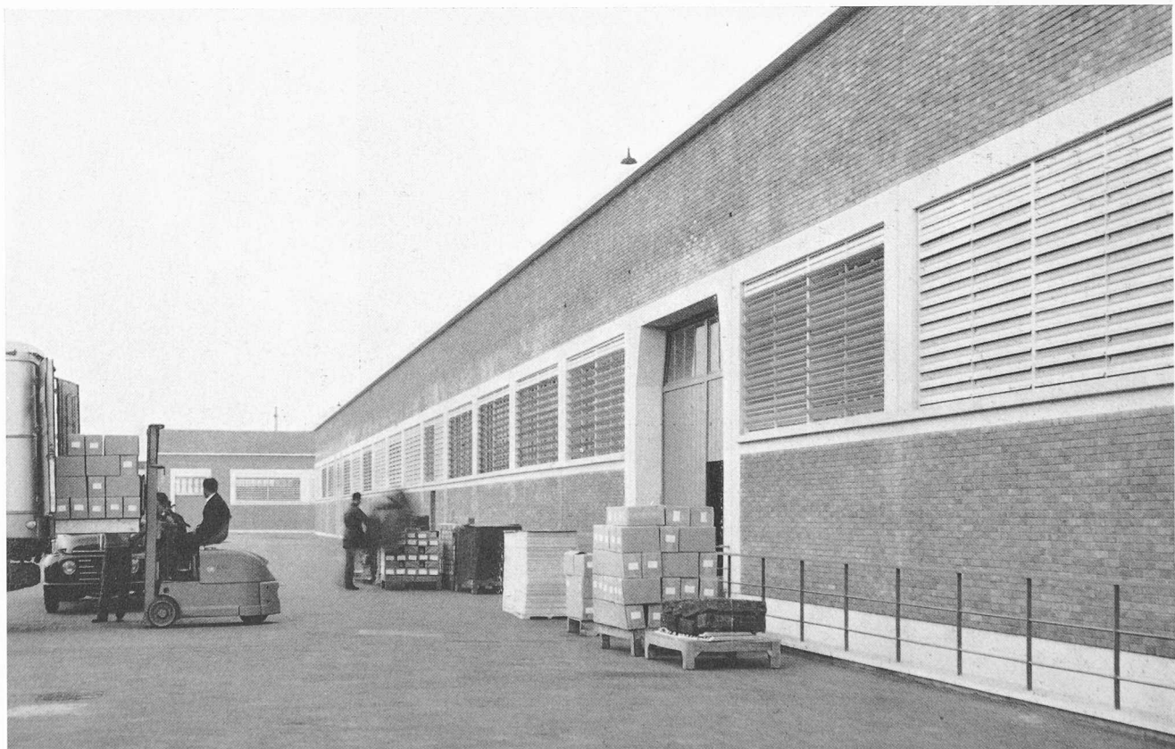
Seitenfassade mit Lamellenstoren
