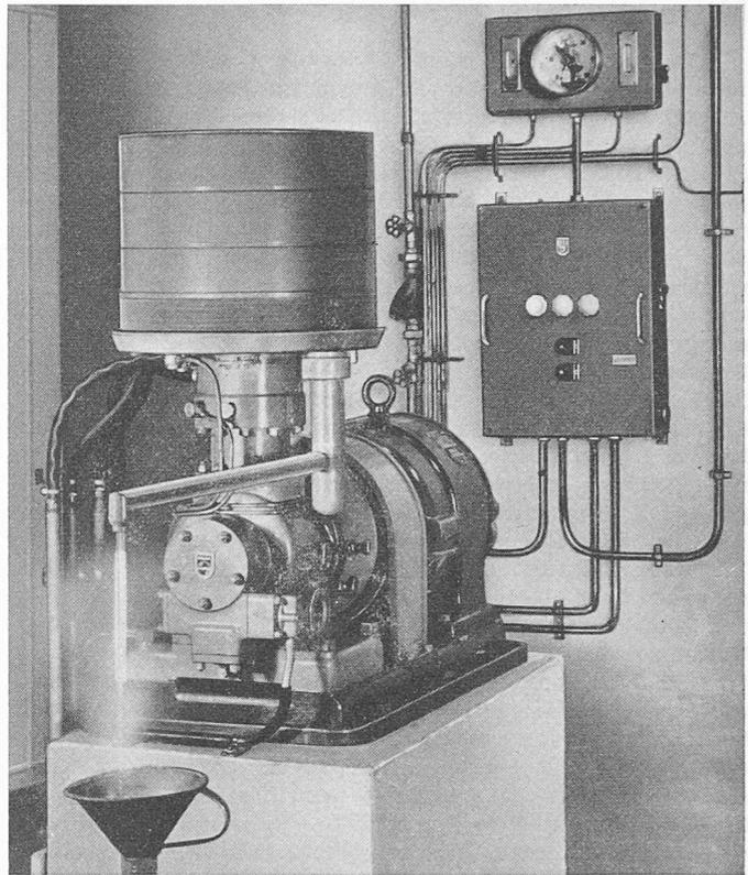
Bild 5. Philips-Gaskältemaschine, vollständige Anlage
