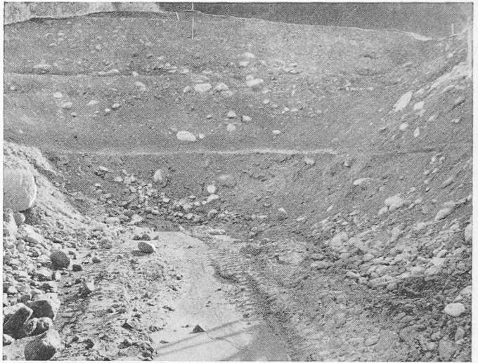
Bild 3. Herbst 1957; grosser, mit Trax ausgeführter Sondierschlitz
