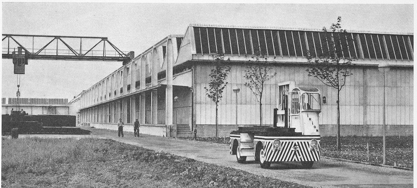
Bild 21. Südseite des Kleinmaterialmagazins
