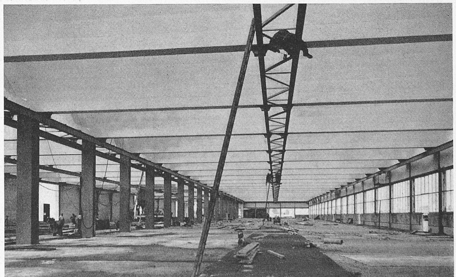
Bilder 6 und 7. Die Weichenbauhalle im Rohbau (Kranbahnmontage)
