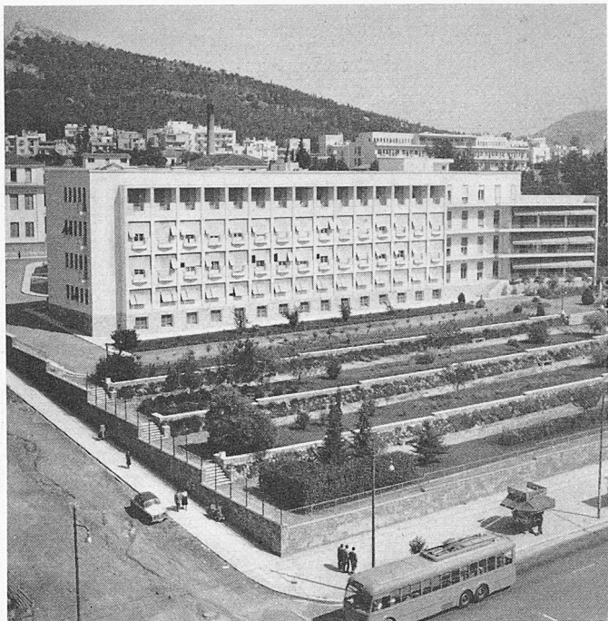
Militärspital in Athen, Architekt Biris
