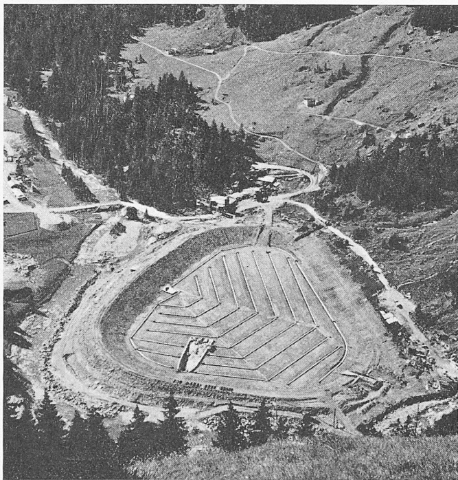
Bild 10. Ausgleichbecken Corina, Pian San Giacomo, Kraftwerk Mesocco. Anordnung der Drainageleitungen und der Kontrollschächte; getrennte Ableitung für Hang- und Sohlenentwässerung
