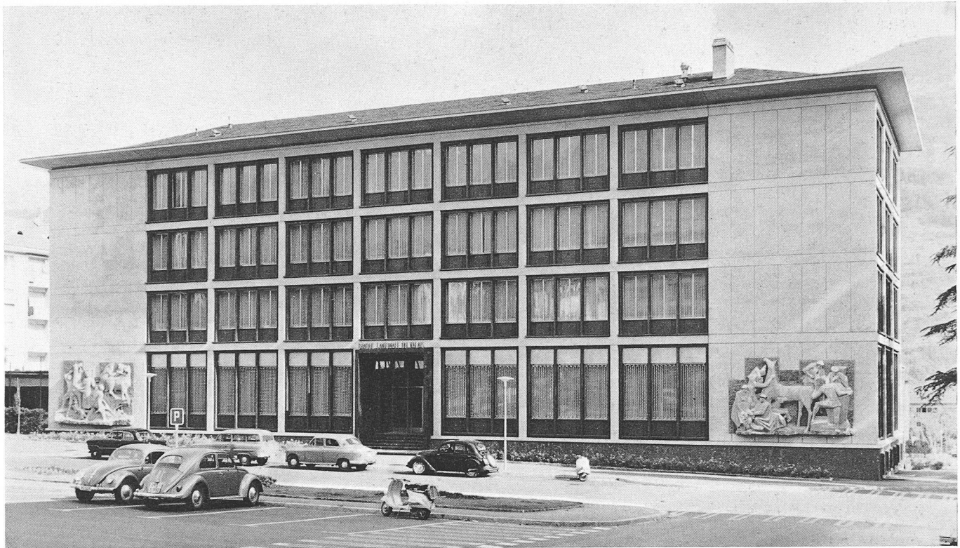
Façade principale, reliefs de Remo Rossi
