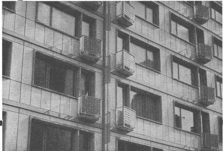
Ausfachung eines Beton-Skelettbau
