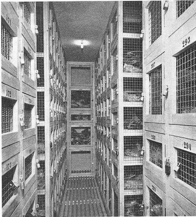
Bild 1 Kaltraum mit Holzfüchern für -18/-20^{\circ}\text{C}
