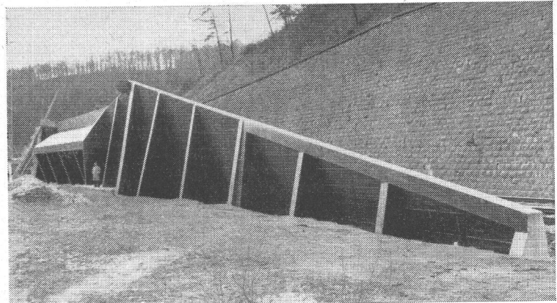
INERTOL-Schutzanstrich für Stützmauer Autostrasse Nr. 15 Schaffhausen — Thayngen
