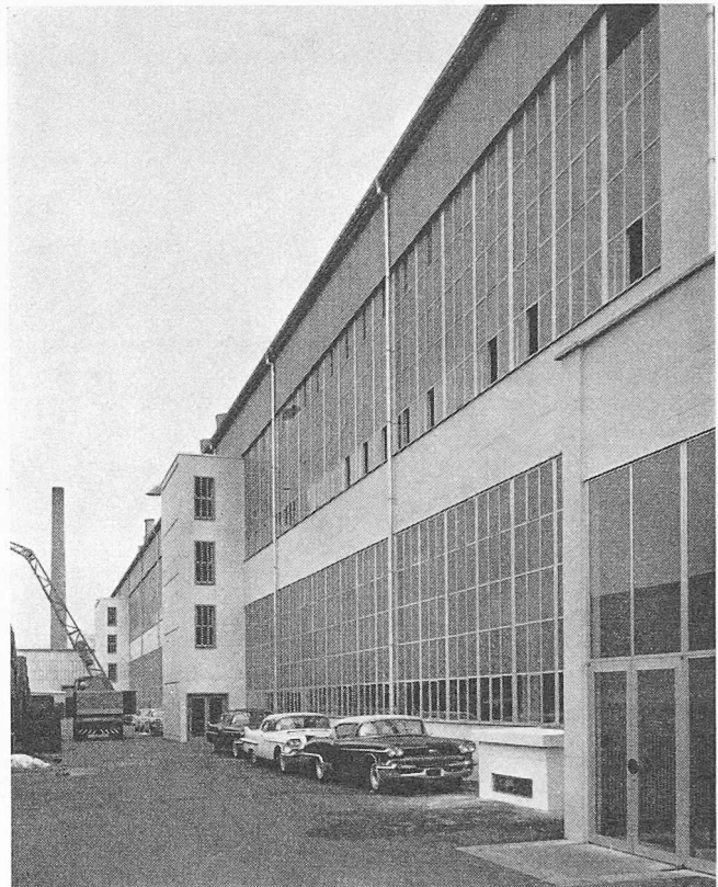
Bild 4. Nordwestfassaden des Neubaus 1957 für das Montagegebäude vom Arbeiteringang aus; Treppenhäuser vorspringend
