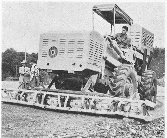
Bild 18. Jackson-Compactor montiert auf Hough -Pneuladeschaukel mit zwei aufgebauten Stromerzeugungs-Aggregaten.
