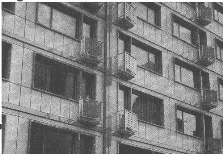
Ausfachung eines Beton-Skelettbauens
