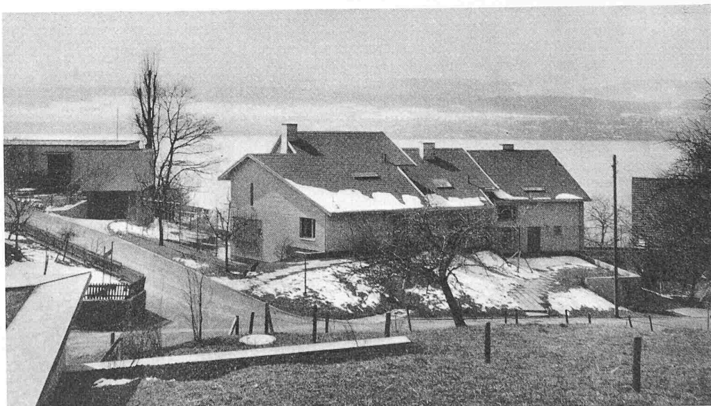
Dreiereinfamilienhaus in einem Zürichseedorf, gedeckt mit dunkelgrauen Eternitschiefern. Architekten Ed. Neuenschwander und M. Mettler
