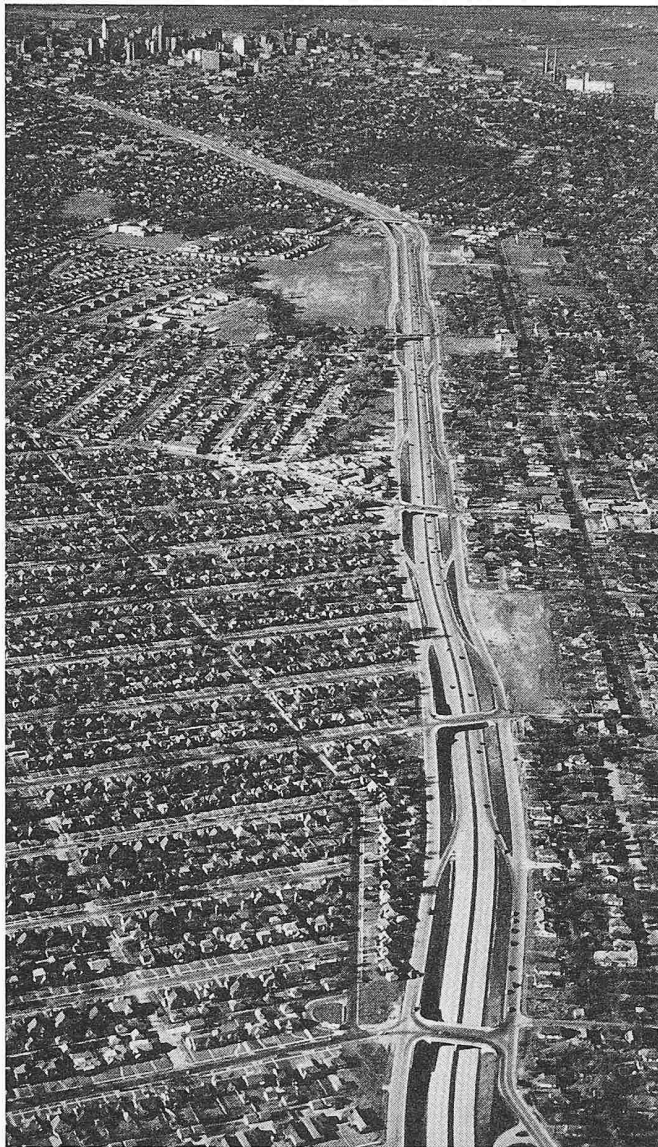
Bild 12. Expressstrasse in Dallas (Texas). Im Hintergrund der Stadtkern. Tiefstrasse mit seitlichen Auf- und Abfahrtsrampen, enge Verknüpfung mit den seitlichen Parallelstrassen und guter Anschluss an das örtliche Strassennetz. Grosser Flächenbedarf
