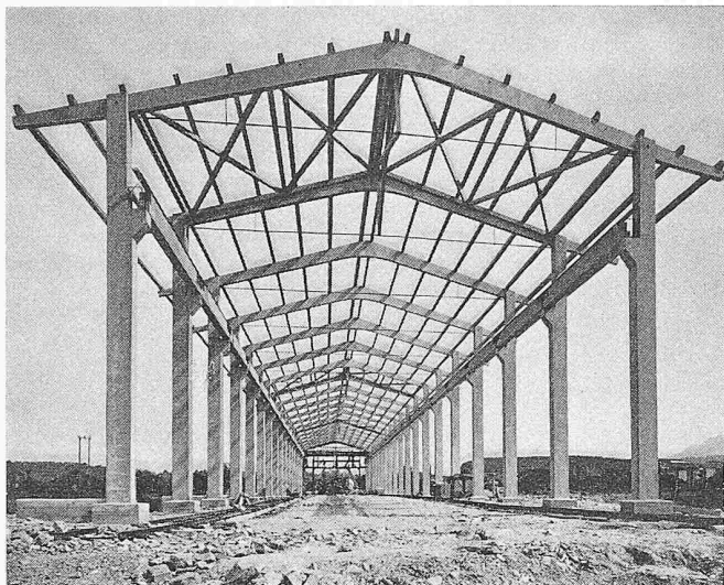
Bild 5. Werkhalle der Bauunternehmung Gebr. Brun in Emmenbrücke
