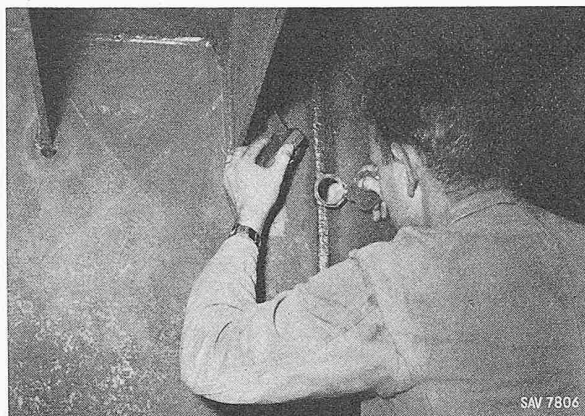
Bild 42. Schweissnahtkontrolle von Auge mit der Lupe
