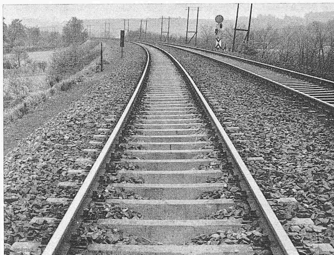
Bild 2. Die Schwelle B55 in einem Gleis der DB
