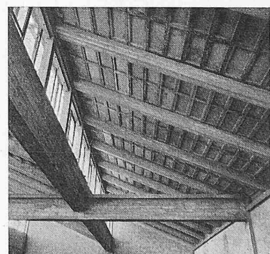
Strickwarenfabrik BMD in Diep River, Nordlichter: drei Schalendächer 26 \times 14 m, 7 cm stark, und zwei Dächer mit vorfabrizierter ebener Dachkonstruktion. Zu beachten sind die grossen Fensterhöhen, bedingt durch den Fabrikationsprozess
