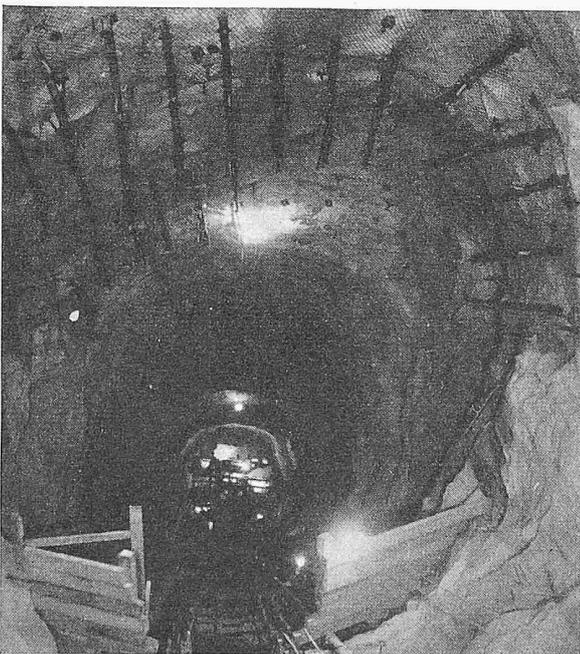
Bild 6. Ankerung durch Keilschlitzanker, Netz und Profileisen im 45° geneigten Schrägschacht des Kraftwerkes Forçacava (Brasilien);  $F = 44$  m<sup>2</sup>
